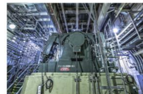
正電圧からの電力供給が失われた場合に自動で起動し、原子炉等を安全に停止するための電力を供給します。
