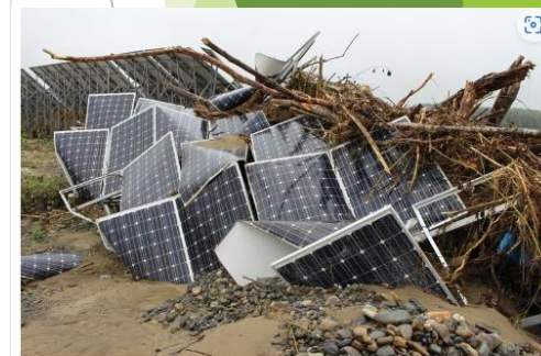
台風による水害で被災した太陽光パネルの例
