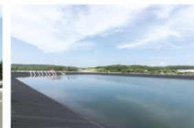
原子炉を冷却する手段の多様化として、大容量の水を確保するための容量約4500立方メートルの貯水池を設置しました。貯水池容量は約2万トンで、6-7号機の原子炉使用燃料プールに淡水を約1000トン以上供給することができます。(1号機には使用済み)
