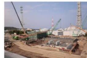
発電所内の建設の進展を受けないがスタービン発電機対応の地下に5万リットルの軽油タンクを設置し、燃料である軽油を供給します。
