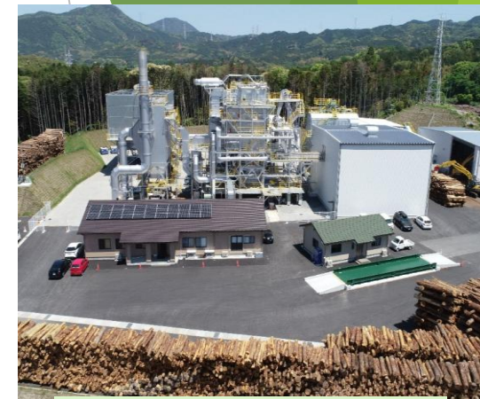
バイオマス発電所
